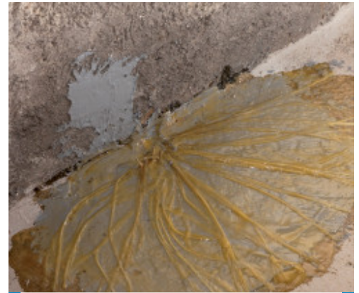
Impregnating the MapeWrap Fiocco cord
